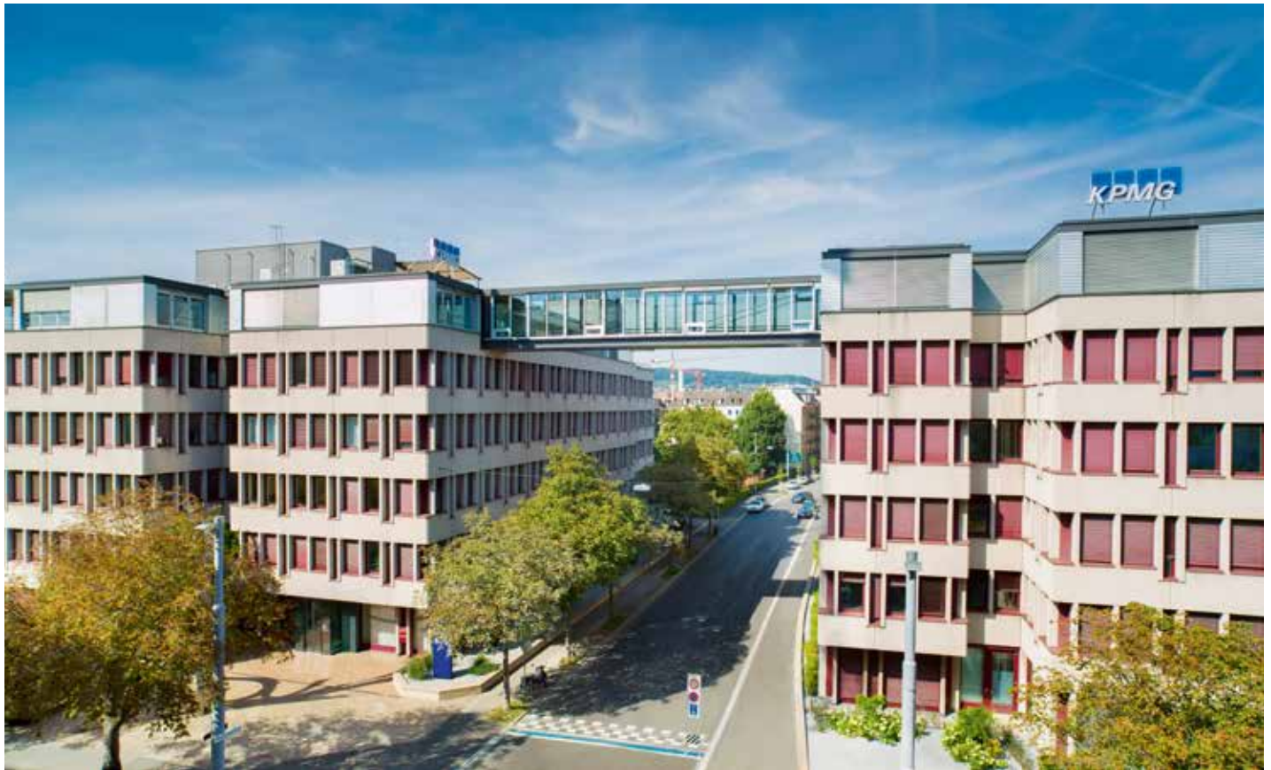
Die Firma KPMG konnte ihre Energieeffizienz durch Optimierungsmassnahmen an den haustechnischen Anlagen steigern (siehe Kasten rechts).
